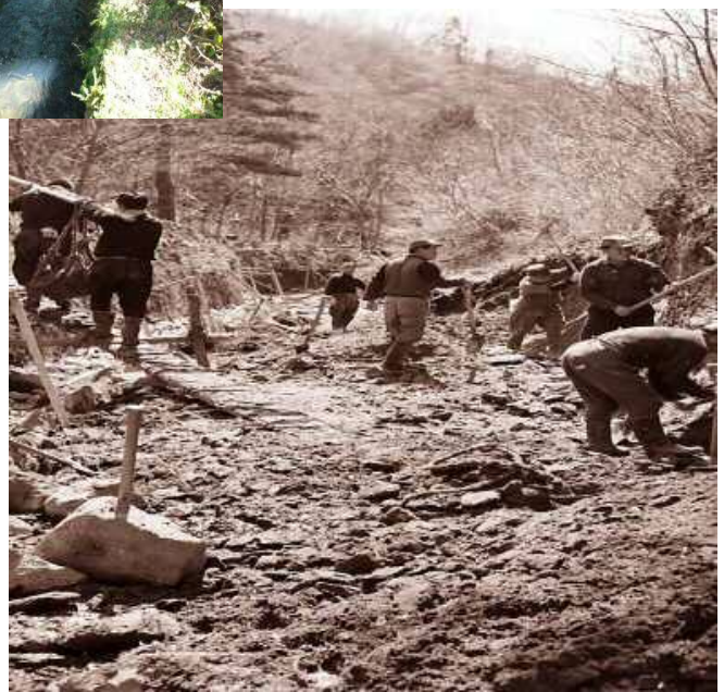
1954年の水路改修工事
