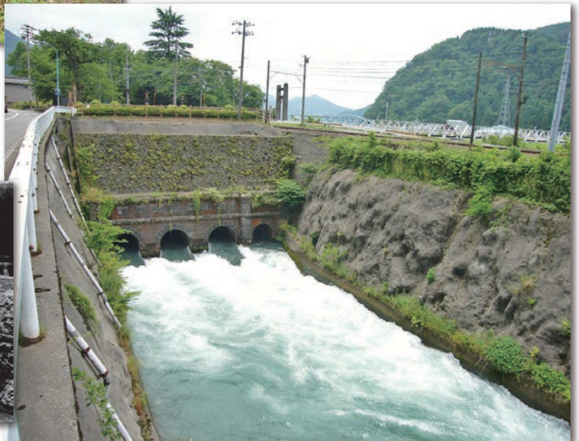
現在の給水口
