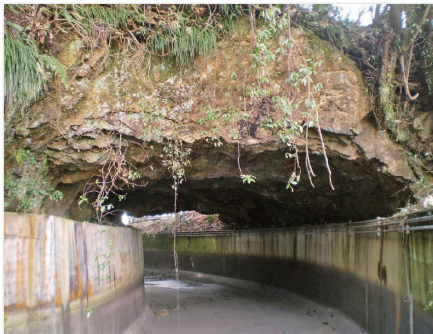
岩盤掘削の痕跡
