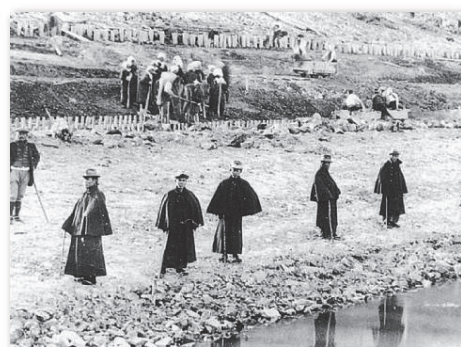
1883年の入鹿池工事
