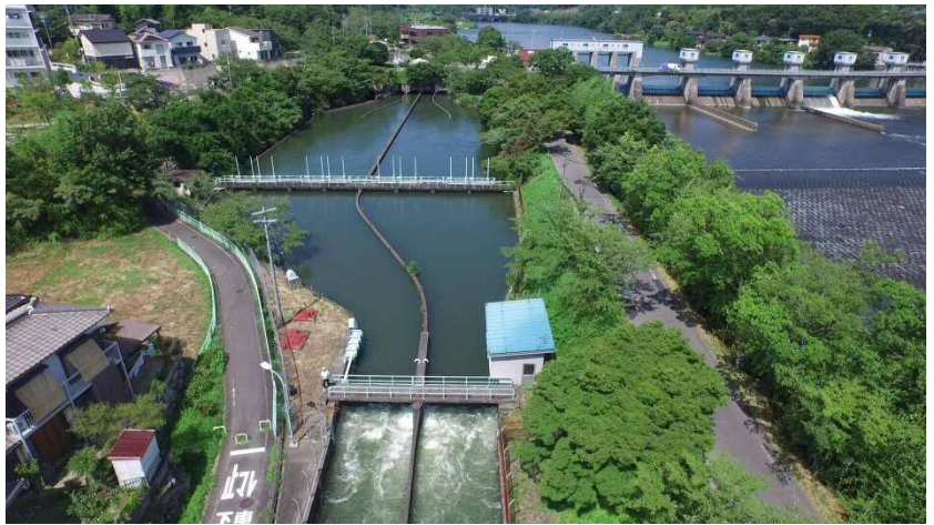
明治頭首工と取水口
