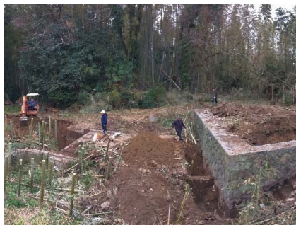
旧取水口樋門発掘の様子
