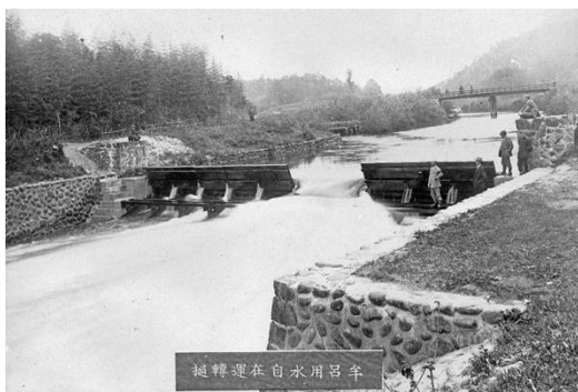
自在運転樋（牟呂用水）
