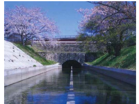
牟呂松原幹線には人造石工法部分が残存
