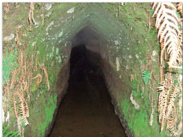
水路トンネル内部
