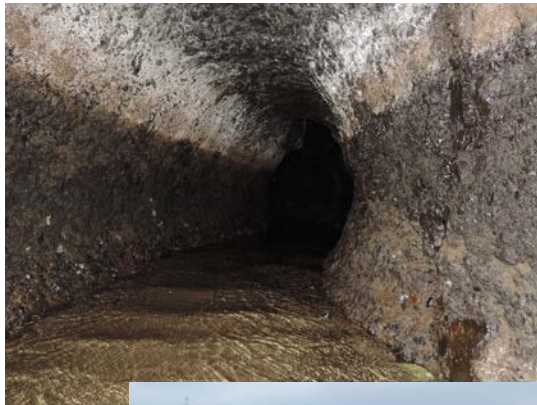
宝永隧道内部
