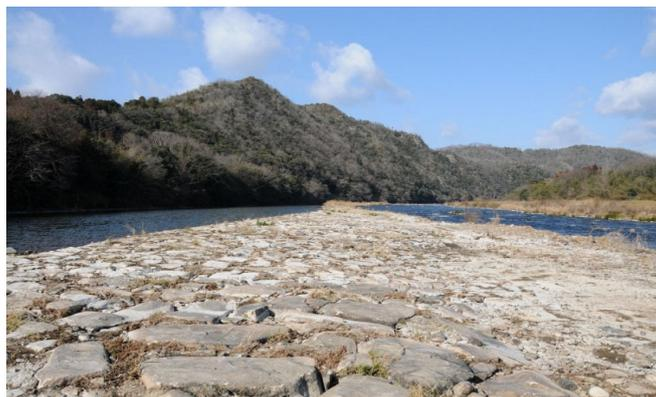
井堰上部の雑草・土砂を撤去し全容を確認
