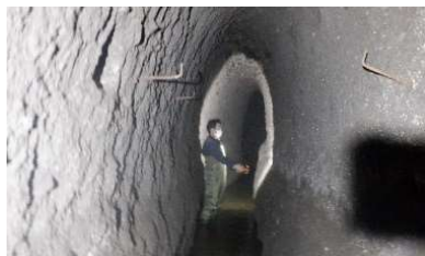
【トンネル内部(導水路)】
