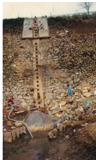
【改修前の斜樋】
