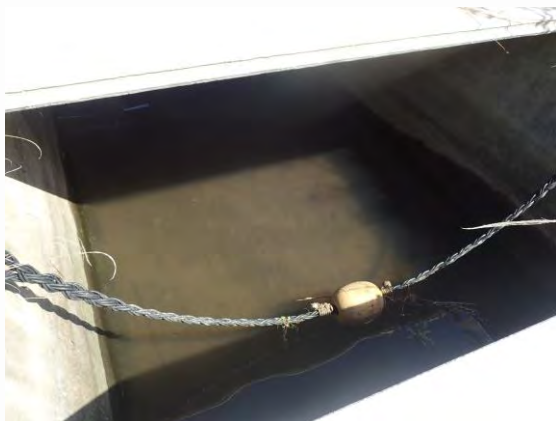
蓋掛け箇所(水草生育せず) 近畿農政局管内での事例
