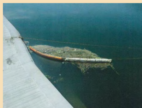
オイルフェンス設置状況
