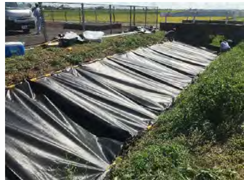
②遮光シート設置状況
