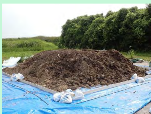
透明ビニールシート被覆前
