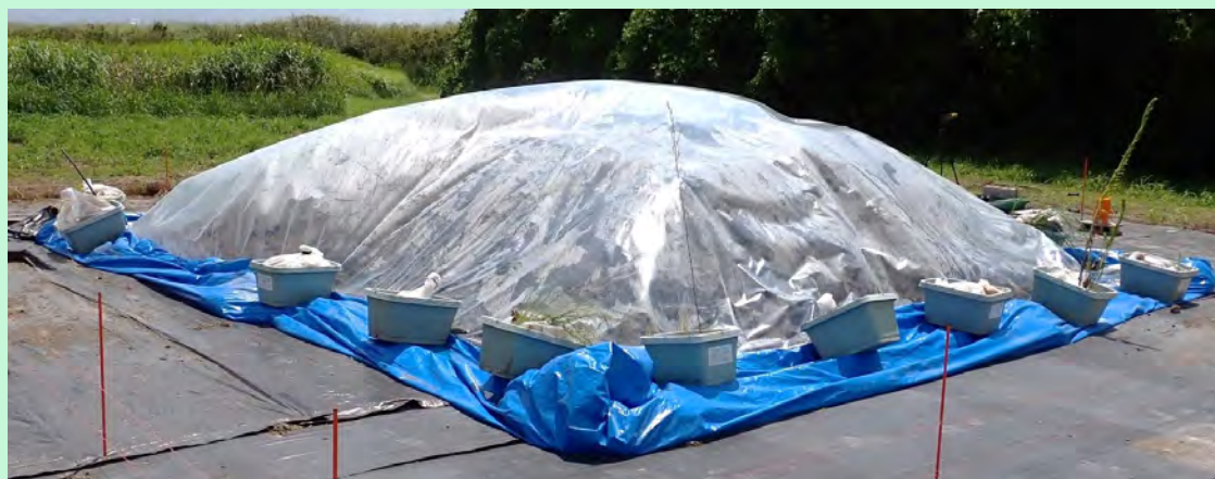
盛土の設置状況
