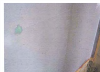
固着防止資材施工
