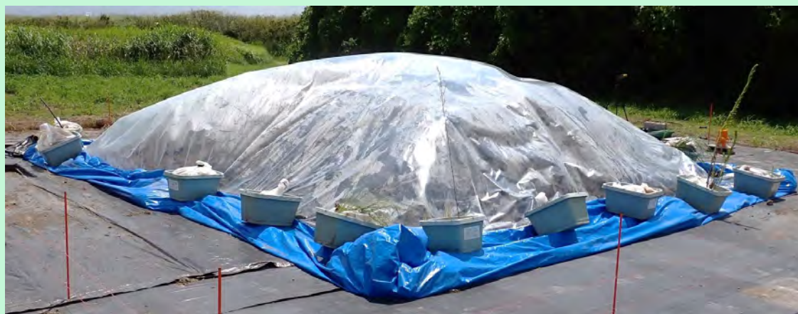
盛土の設置状況
