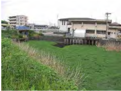
比較的水深が深い調整池における発生状況
