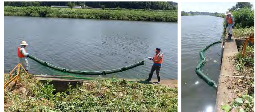
流出防止を目的としたダストフェンス設置例
