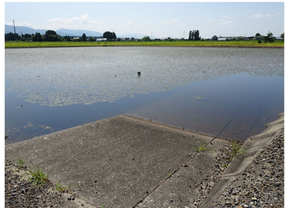
例4) 清掃作業の際に、重機やトラックが進入するためのスロープを設置
