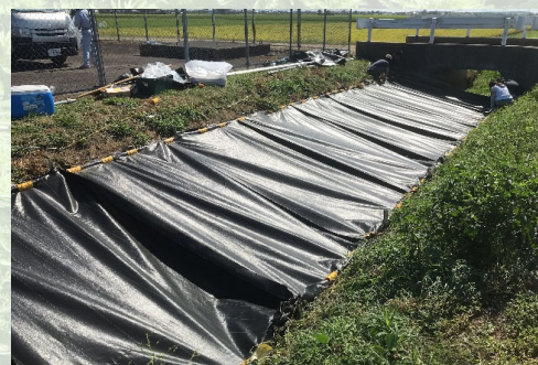
水路上に遮光シートを張った状況
