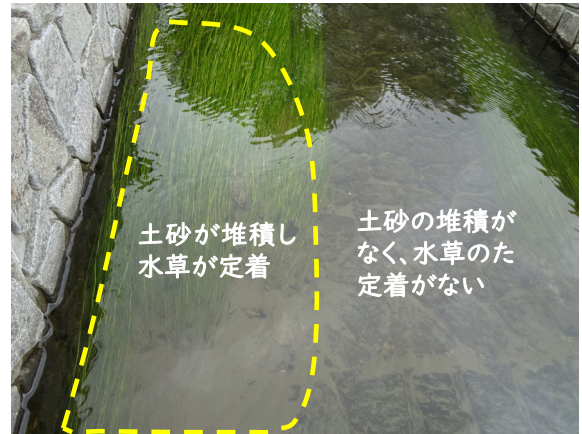
例6) 堆積した土砂を小まめに除去することで水草の定着を抑制
