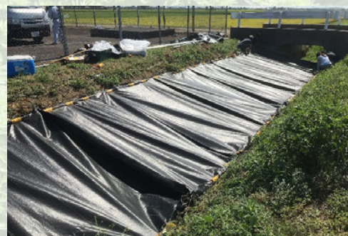
水路上に遮光シートを張った状況
