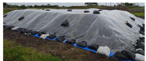
水路工事で発生した土を陽熱処理している様子
