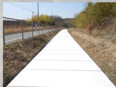
水路の蓋掛けによる遮光
