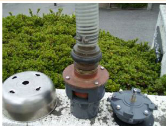
アタッチメントを用いた接続状況
