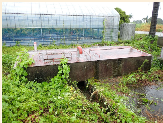
排泥工（パイプラインに併設）
