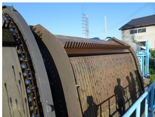
揚水機場の取水口に除塵機を設置
