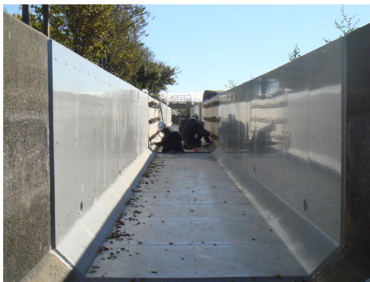
図 100 カワヒバリガイに備えた固着防止資材の塗布 (手前：塗布前のコンクリート壁（灰色部分） 奥：固着防止剤塗布後（白色部分）)
