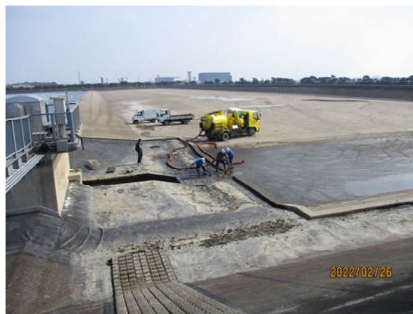
図 97 水槽内に高さ 1 m 程度の隔壁を設けている調整池の事例
