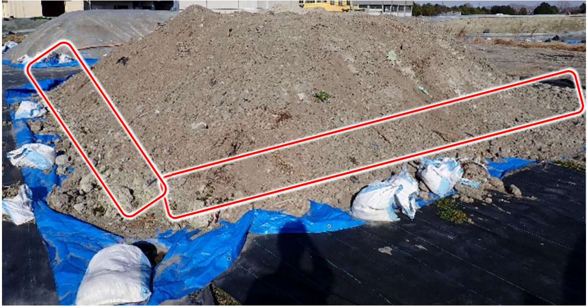
図 46 盛土の裾部（赤枠付近）
