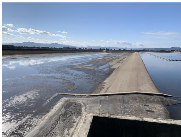
図 97 水槽内に高さ 1 m 程度の隔壁を設けている調整池の事例
