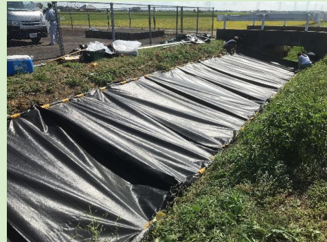
②遮光シート設置状況
