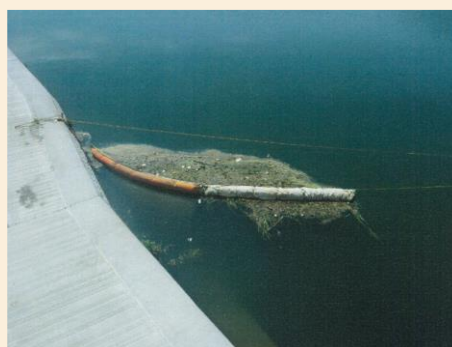
オイルフェンス設置状況
