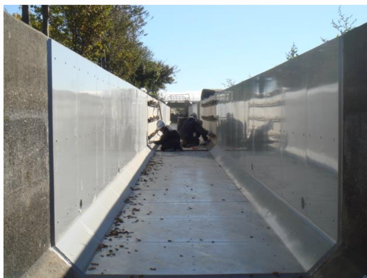
図 100 カワヒバリガイに備えた固着防止資材の塗布 (手前：塗布前のコンクリート壁（灰色部分） 奥：固着防止剤塗布後（白色部分）)
