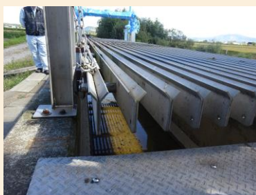
スクリーンバーの断面 (Y型の形状)
