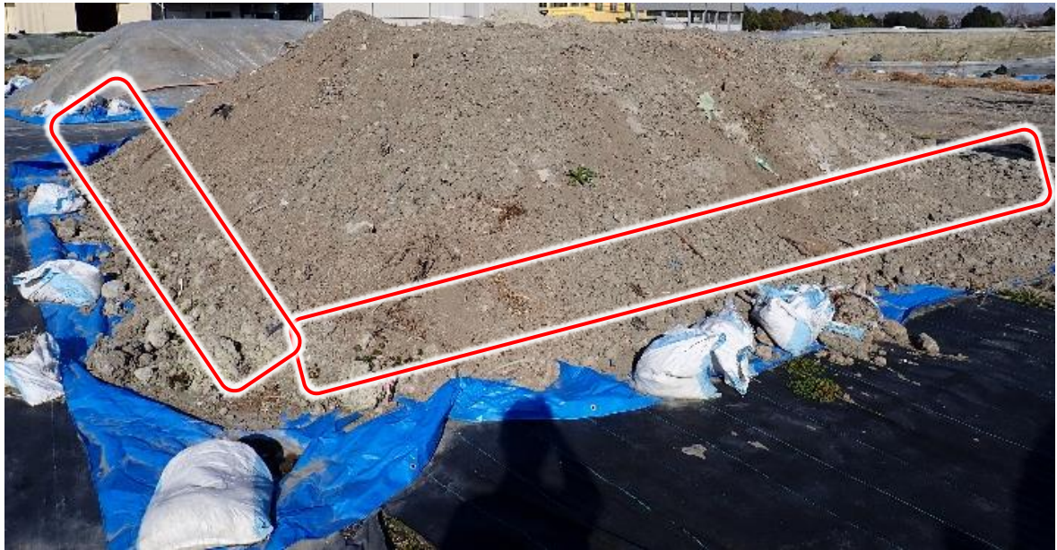
図 46 盛土の裾部（赤枠付近）
