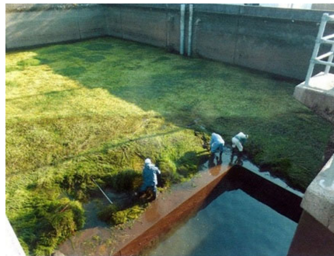
オオカナダモの繁茂により、貯水容量が減少し調整機能が低下した事例
