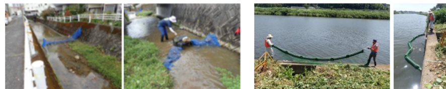
流出防止を目的とした網の設置例
