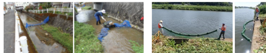
流出防止を目的とした網の設置例
