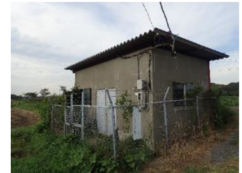
小規模ポンプ場
