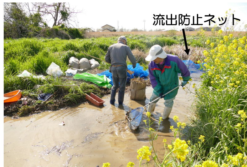
下流側で洗い出された断片を回収
