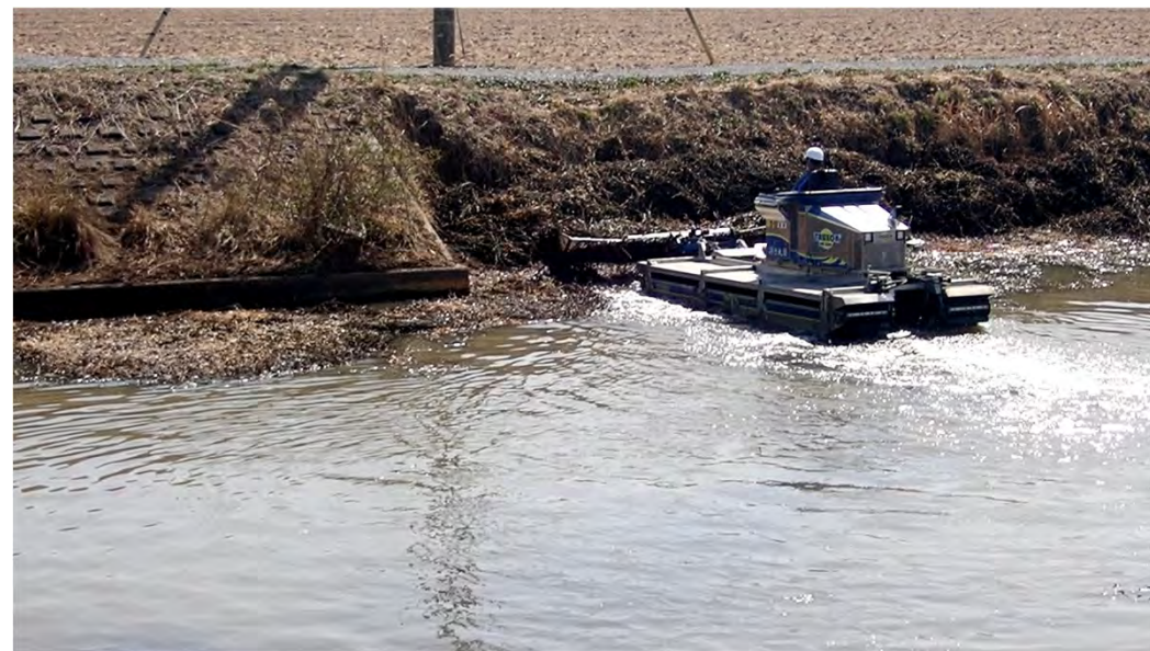
作業船を用いた沖合からの群落除去
