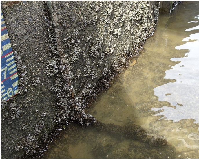
開水路の目地部分
