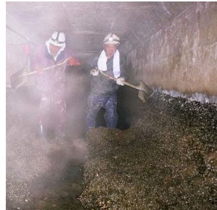
水路トンネル壁
