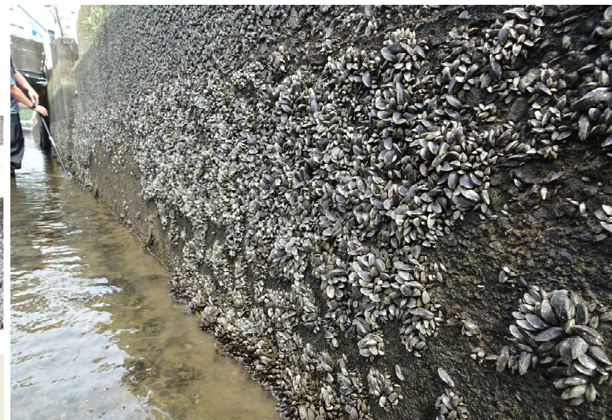
水路壁一面に付着したカワヒバリガイ
