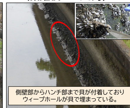
水路壁への付着状況の1年間の経年変化
