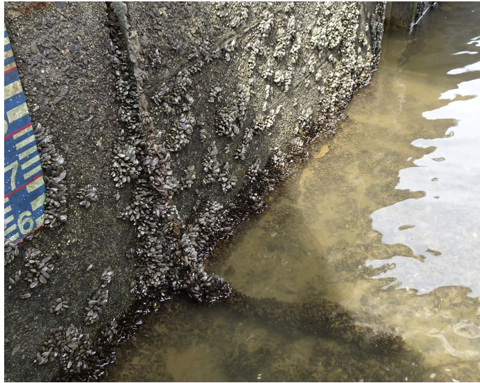
開水路の目地部分
