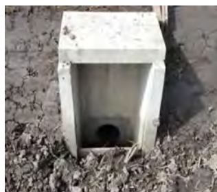
落水口の整備
