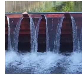
水膜振動対策（副スポイラー設置）
