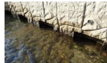
生態系配慮施設（魚巣ブロック）
