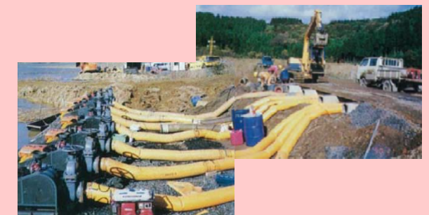
応急排水ポンプをポンプ会社や農政局より借用し、湛水排除を行った。
