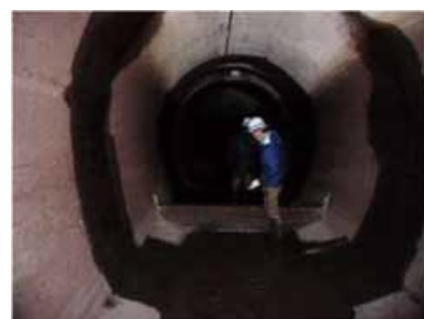
写真 2-4 水路トンネルの管理状況 (目視調査)
