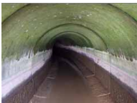
写真 2-3 農業用水路トンネル内部の状況
