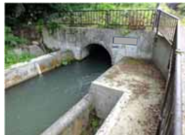
参考 2-13 幹線用水路(ずい道)下流坑口付近(かんがい期)
