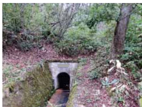
写真 2-2 農業用水路トンネル入口の状況
