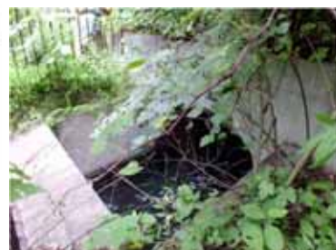
参考 2-10 本坑下流口 明かり部 (かんがい期)
