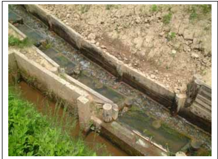
写真-4.4(2) 水田魚道内の流況・鎌谷川
