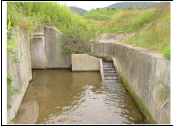
写真-4.5 魚道ブロックの設置例
