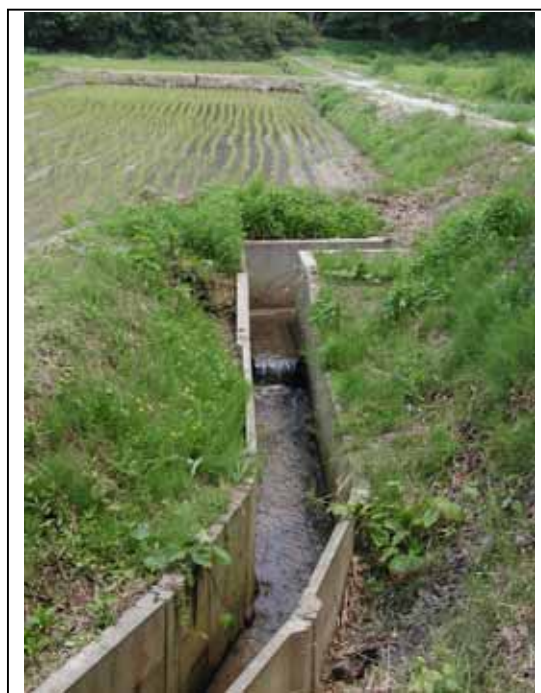
写真-3.4 コンクリート化された水路
