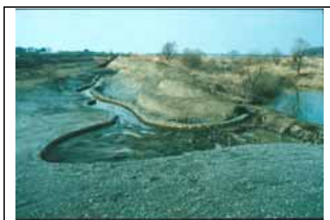
上：写真-1.3(1) 施工中
