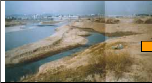
上：写真-1.1(1) 施工中
