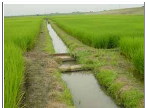
写真-2.1 土羽水路の例
