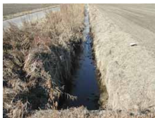
写真-3.8 B3 全体に水深が浅く、部分的に深い箇所がある
