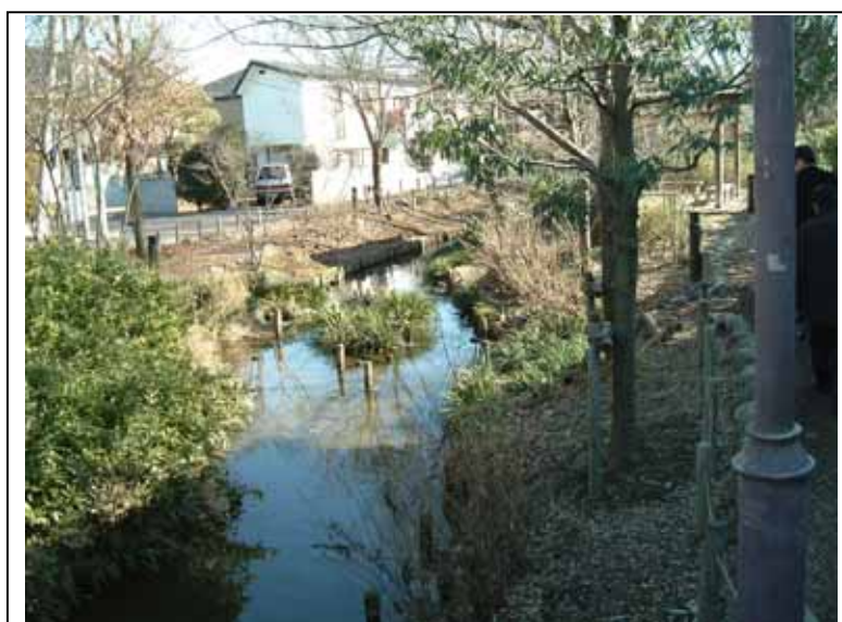
写真-4.7 土羽水路の整備例
