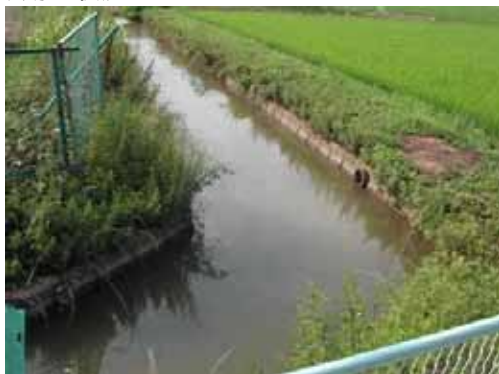
写真-3.6 B1~B2 コンクリート三面張り
