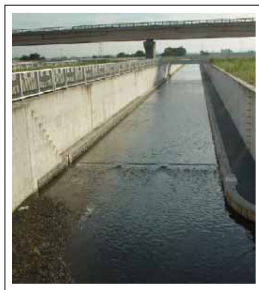
写真-1.5 紀の川水系紀の川 紀の川大堰 人工河川式魚道
