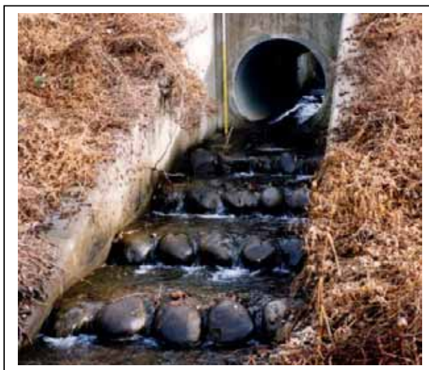
写真-4.1 階段式魚道（自然石タイプ）・小貝川
