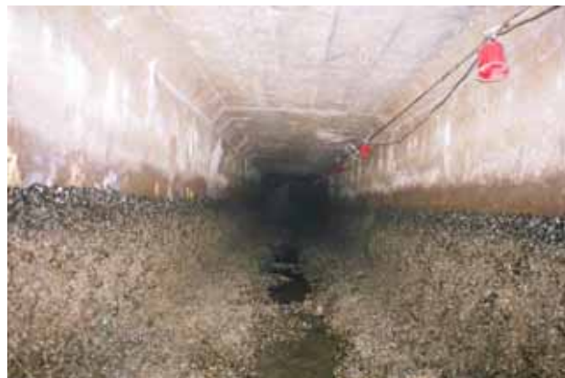
貯水池の幹線導水トンネルに発生し付着したカワヒバリガイ
