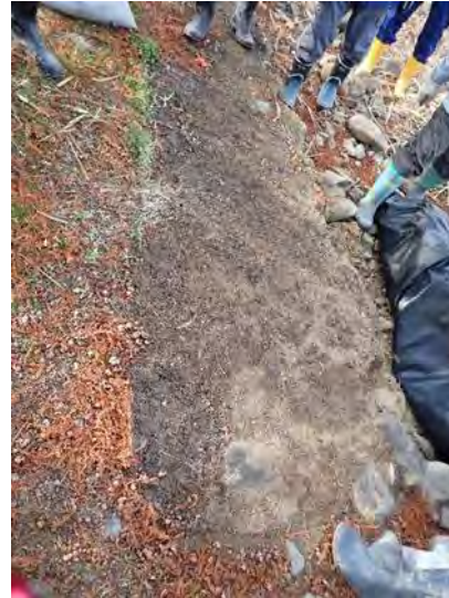
厚さ0.5mmのゴムシート（遮光率100%）による 水位変動下のため池法面における群落抑制
