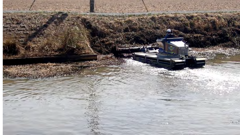
作業船を用いた沖合からの群落除去
