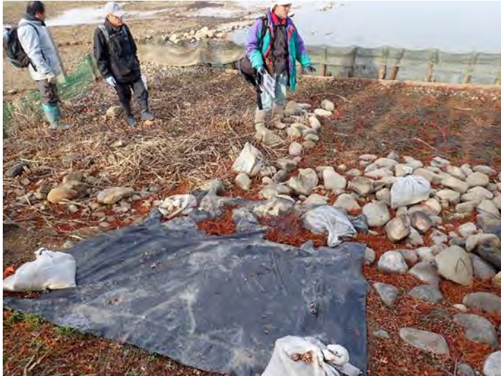
厚さ0.5mmのゴムシート（遮光率100%）による 水位変動下のため池法面における群落抑制
