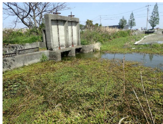
水路を閉塞し、取水・排水の障害となる
