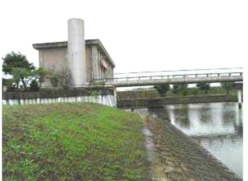
排水機場の法面での生育状況
