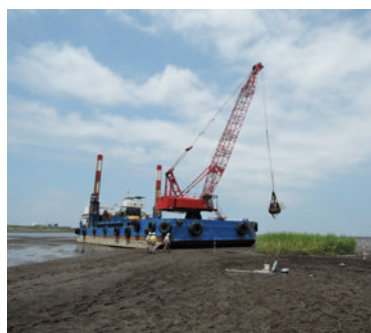
ガットバージ浚渫船による 工事の状況
