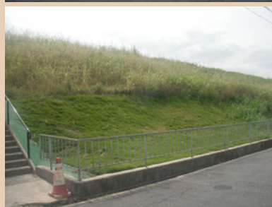
植生転換の施工直後の状況（上）と植生転換箇所の経過状況（下）
