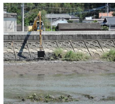
バックホウによる 工事の状況
