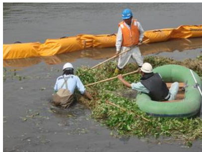
オイルフェンスで囲んだ上での除去
