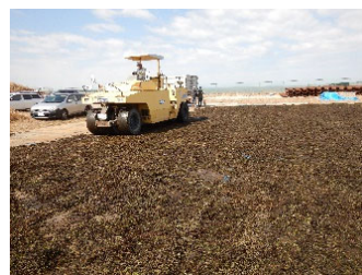
ロードローラーによる押しつぶしと ネットによる固定（霞ヶ浦除去対策実験※）
