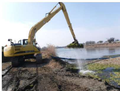
バックホウを用いた除去
