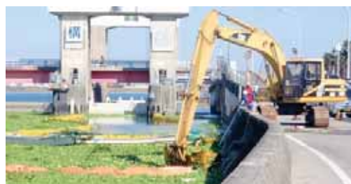
スケルトンバケットを装着したバックホウによる水揚げ
