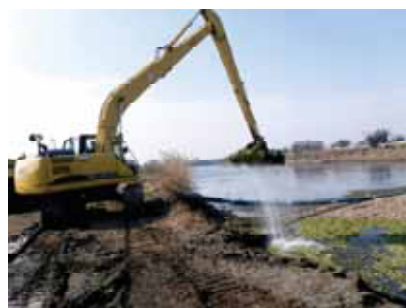
バックホウを用いた除去
