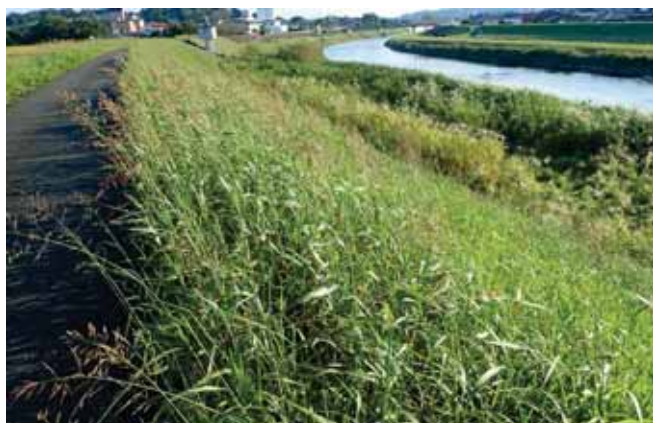
河川堤防上に繁茂するセイバンモロコシ
