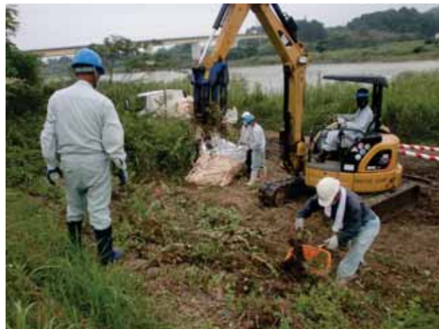
手作業と重機により根こそぎ除去(小丸川)
