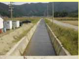
整備された水路（3面張り・現場打ち）
