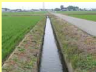
整備された水路（3面張り・大型U字溝）
