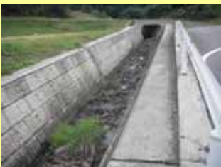
整備された水路（2面張り・ブロック積）
