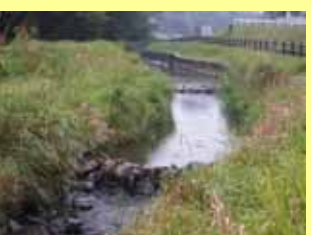
生きものに配慮した水路
