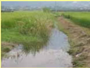
平地の素堀り水路
