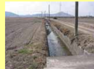
非かんがい期に水のないコンクリート水路
