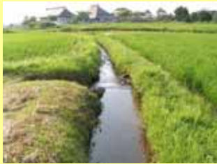
中山間の素堀り水路
