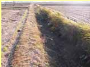
非かんがい期に水のない土水路
