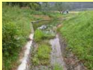
生きものに配慮した水路（瀬・淵）
