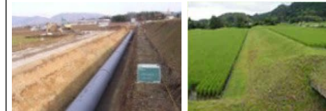
水路のパイプライン化や法面の緩傾斜化による草刈り、泥上げ作業等の軽減
