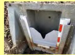
降雨時は、V字部分の断面に応じて排水されるため、堰板操作が不要。(最大で10cmの雨水の貯留が可能)
