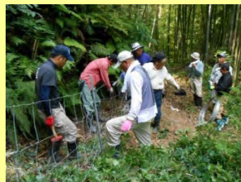
防護柵の直営施工
