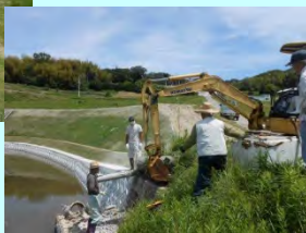
ため池付帯施設の直営施工
